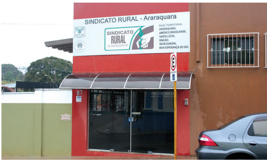
Sede do Sindicato Rural em Araraquara, na Avenida Feijó, construída na década de 60
