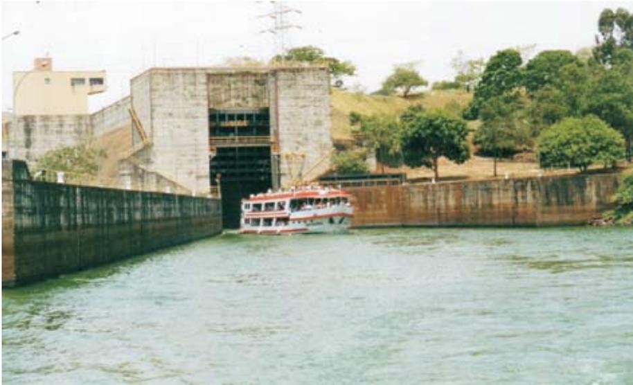
Figura 15. Embarcação adentrando em eclusa na hidrovia Tietê-Paraná (Barra Bonita, SP). A eclusa é um tipo de elevador hidráulico que transporta as embarcações de um lado para outro da barragem. Foto do autor, 2003.
