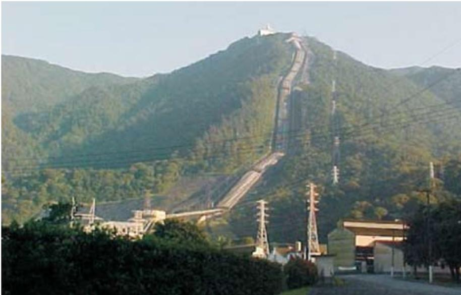
Figura 16. Usina Henri Borden (SP), aproveitando o desnível da escarpa da Serra do Mar para gerar energia com as águas da represa Billings que descem nas tubulações. Foto do autor (2001).
